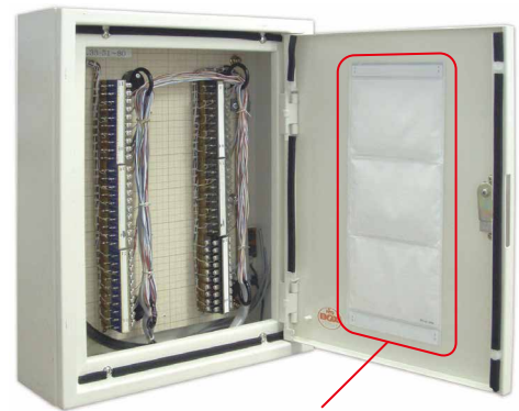
通信専用端子盤へのG-ブレス施工例
